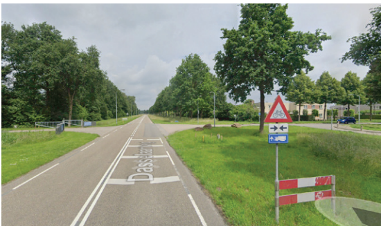
Huidige situatie Dasselaarweg t.h.v. manege Bron: Google Streetview
